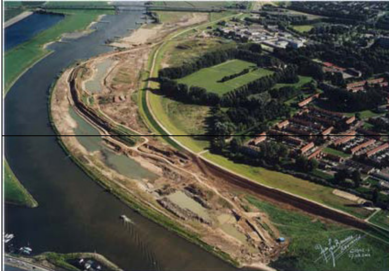
Dijkteruglegging bij Bakenhof (Arnhem). Over een traject van 1 km is de waterkering c. 500 m landinwaarts teruggelegd. Op die manier is extra ruimte voor hoge rivierafvoeren gemaakt. Het gebied ontwikkelt zich als een interessant wetland en wordt nu frequent bezocht door wandelaars.
